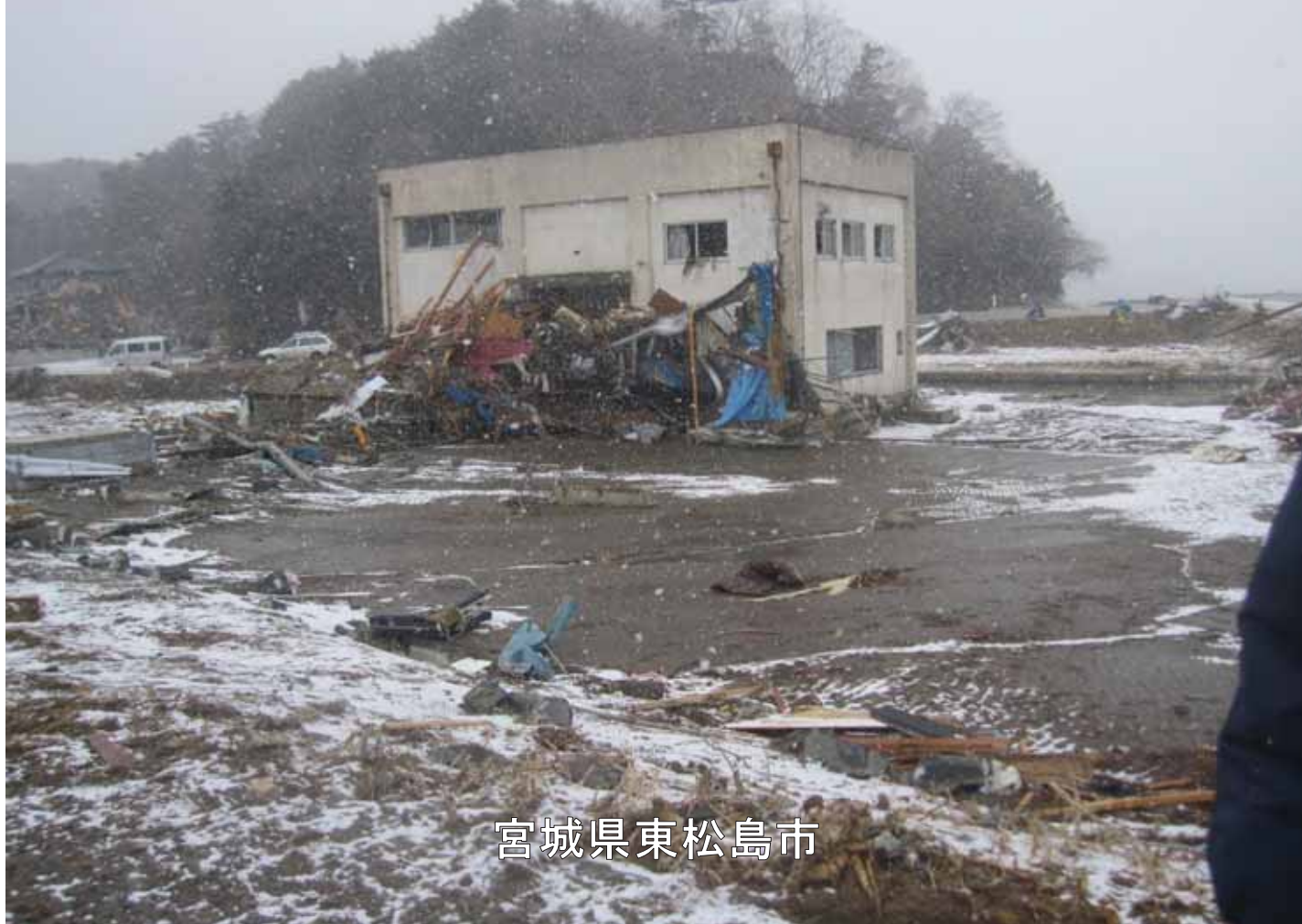
0201_2_018_010189_東松島市(広報)_2011.3.17_東名運河_新町_立石排水機場
